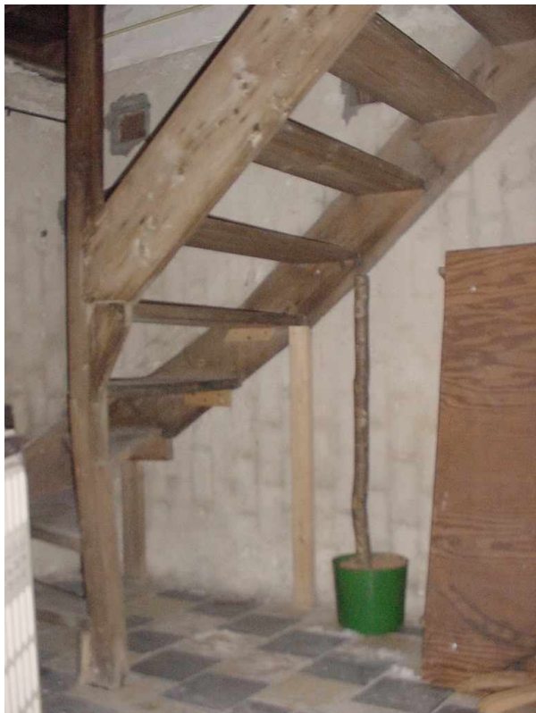
kelder onder loge
