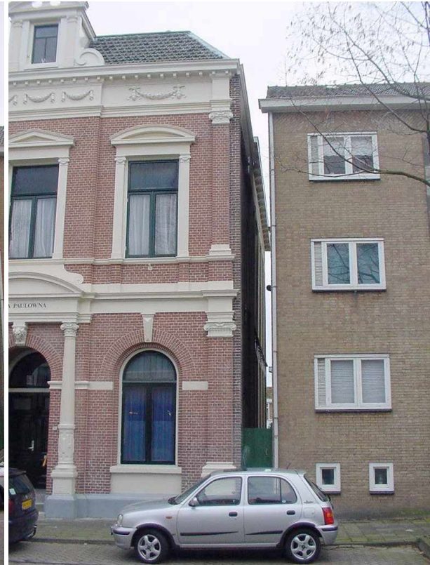
rechterzijde voorgevel vrijmetselaarsloge
