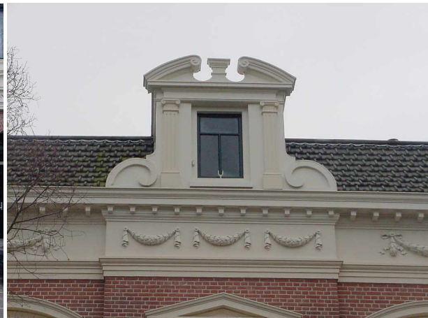
detail dakkapel vrijmetselaarsloge (nr. 61)
